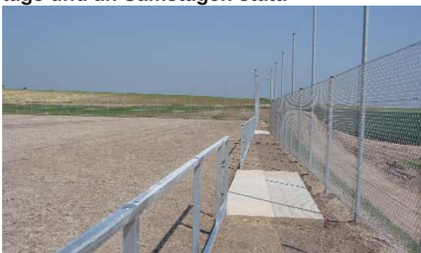
Barriere und Fundament für die Spielerbänke
