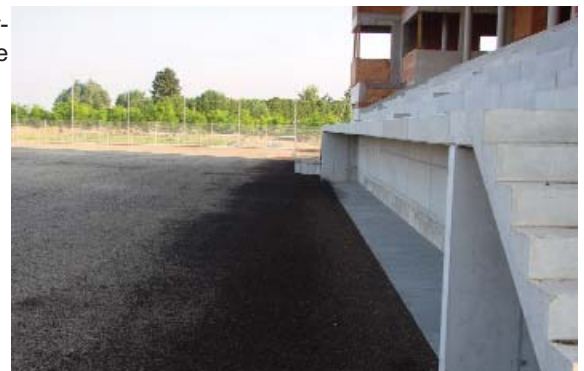
Barriere und Fundament für die Spielerbänke
